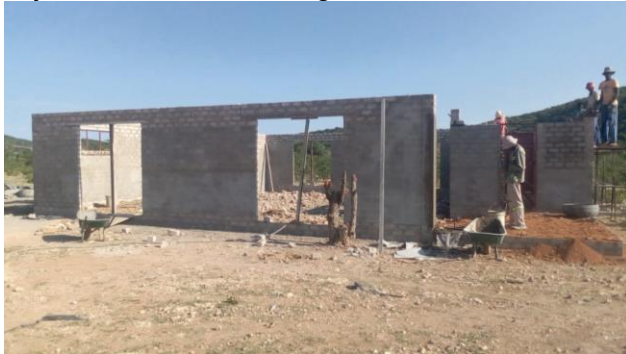
Otjisoko III – Erweiterung, Bau einer Küche
