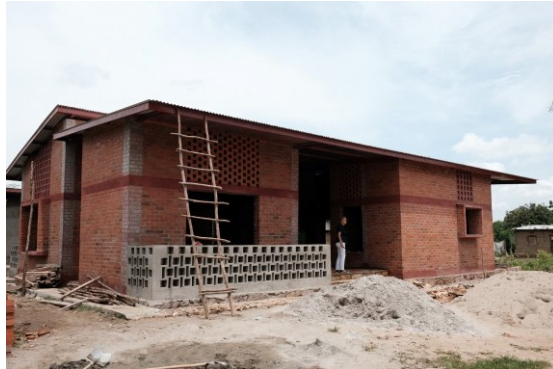
nachher / im Bau:
