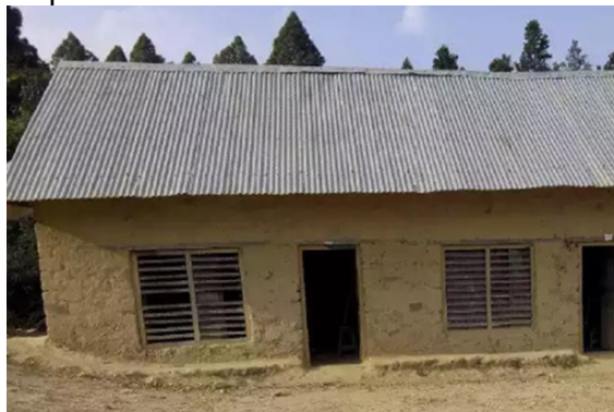
Rupakot II – noch im Bau
